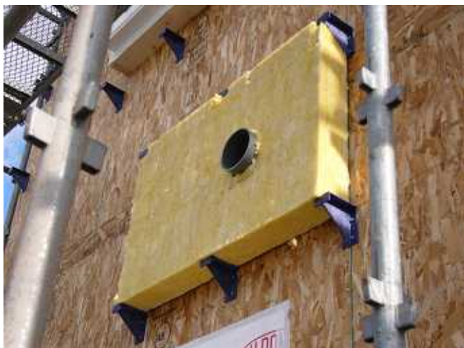
⑧排気ダクト部と断熱材の納まり例
