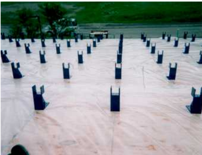
②屋根用ブラケット取付 KM ブラケット R145-38 (45) 取付間隔 W455×H600
