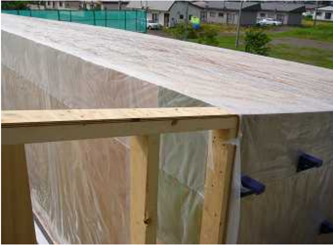
①屋根野地合板、外壁構造合板に気密シート張り
