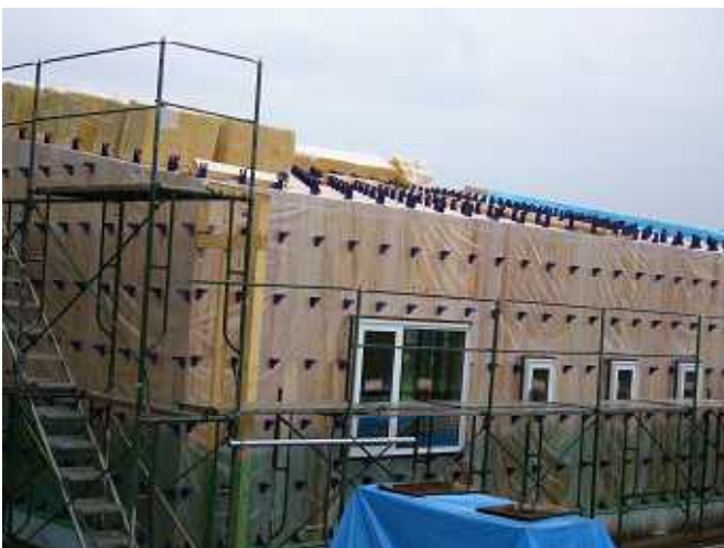
③屋根用ブラケット取付後断熱材ロックウールボードと通気垂木を屋根上に上げておく。
