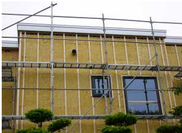
⑨縦胴縁の取り付け
