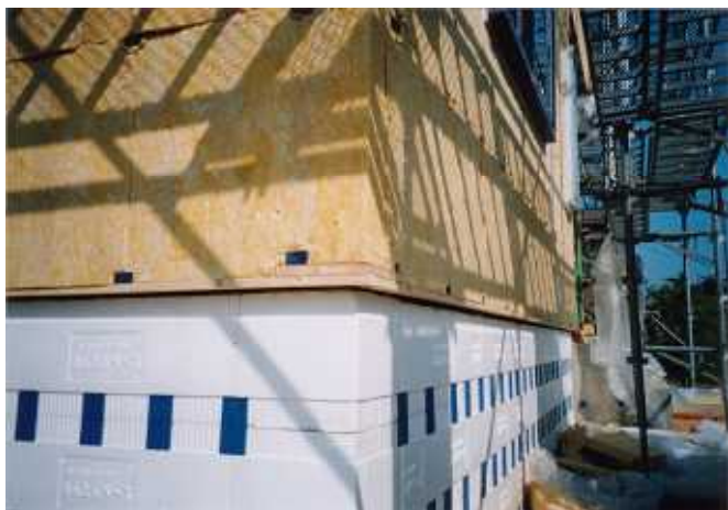
⑦最下段（土台周り）納まり、断熱材受け
