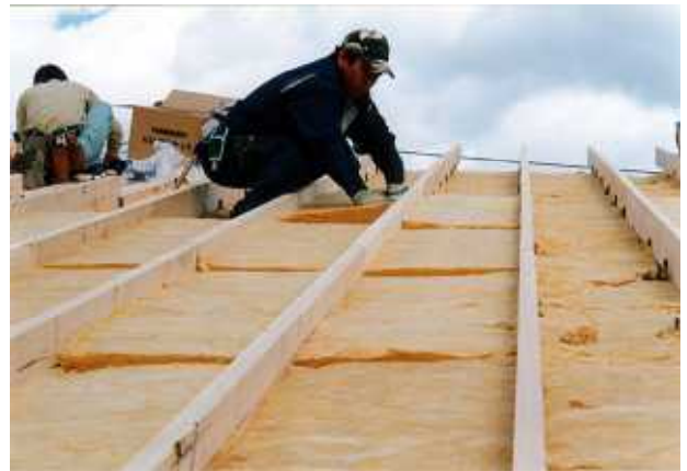
⑤二層目のロックウールボード（厚 50～100mm）取り付け
