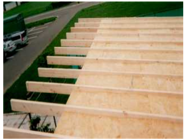
⑦屋根のロックウールボード
