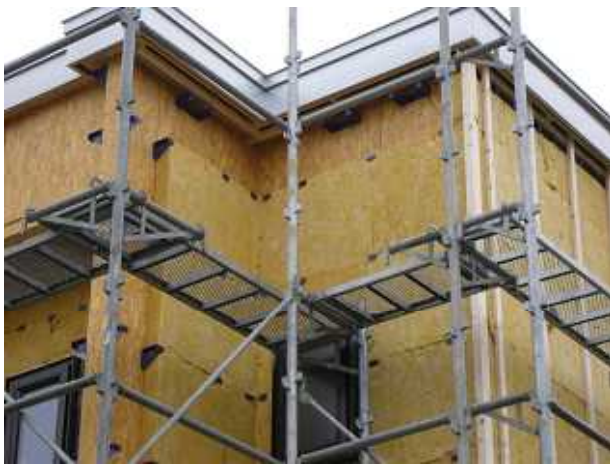
④ロックウールボード取り付け ～ 縦胴縁取り付け
