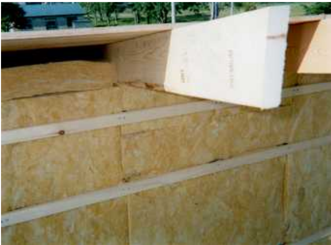
⑪屋根の二層目の断熱材の上部に確保された通気層。
