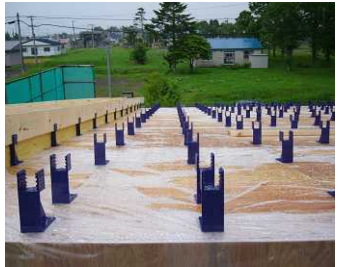
④屋根ブラケット取付後屋根の端部より910ピッチずつ、一層目のロックウールボード、次に通気垂木、その次に二層目のロックウールボードを取り付けて断熱工事を完成させていく。工事中断熱材の上に足を乗せる事が少なくて済む。
