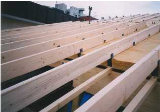
③通気垂木取り付け完了
