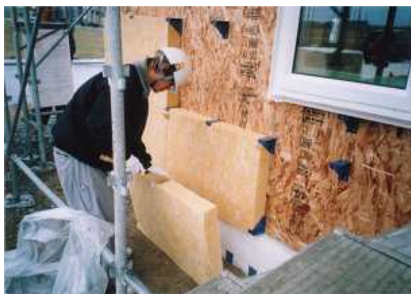
④ロックウールボードのブラケット干渉部をスリット
