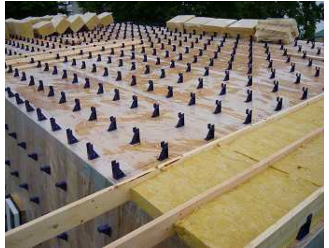
④屋根ブラケット取付後屋根の端部より910ピッチずつ、一層目のロックウールボード、次に通気垂木、その次に二層目のロックウールボードを取り付けて断熱工事を完成させていく。工事中断熱材の上に足を乗せる事が少なくて済む。
