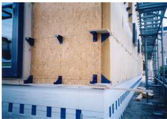
⑥ブラケット、ロックウール、出隅部納まり状況
