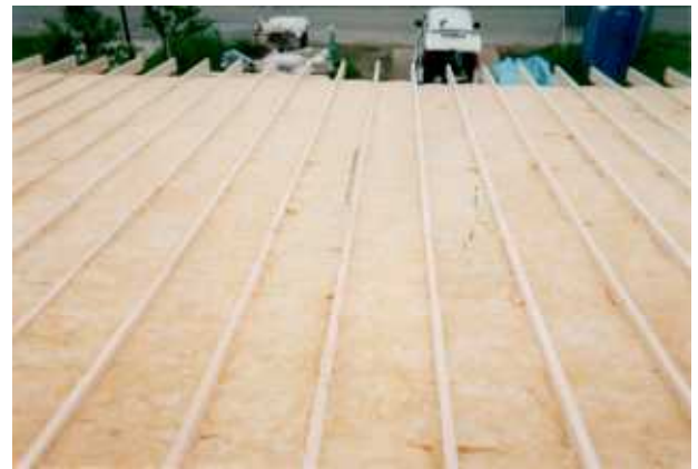
⑧屋根のロックウールボード施工仕上がり状態
