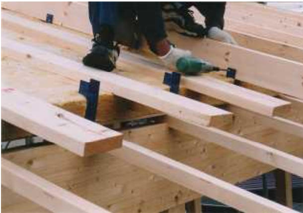
②KM ブラケットに通気垂木（90～140 mm）取り付け（ビス止め）
