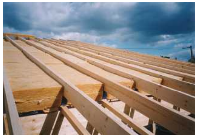
⑥二層のロックウールボード（厚 200mm）が取付けられている。通気層は 40 mm確保されている。
