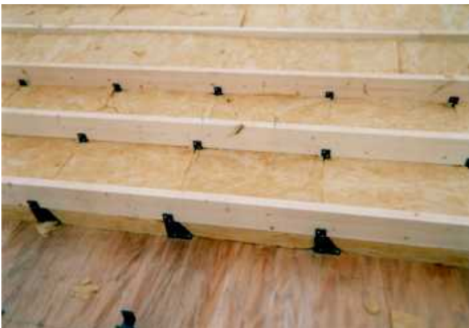
⑥写真（上部）ロックウールボード二層取り付け完了。
