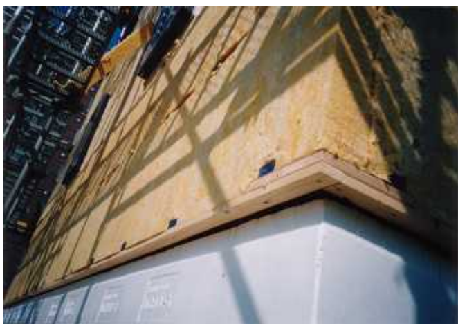
⑦最下段（土台周り）納まり、断熱材受け
