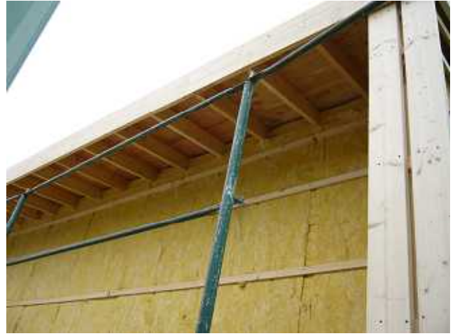
⑫屋根の通気層が確認できる。
