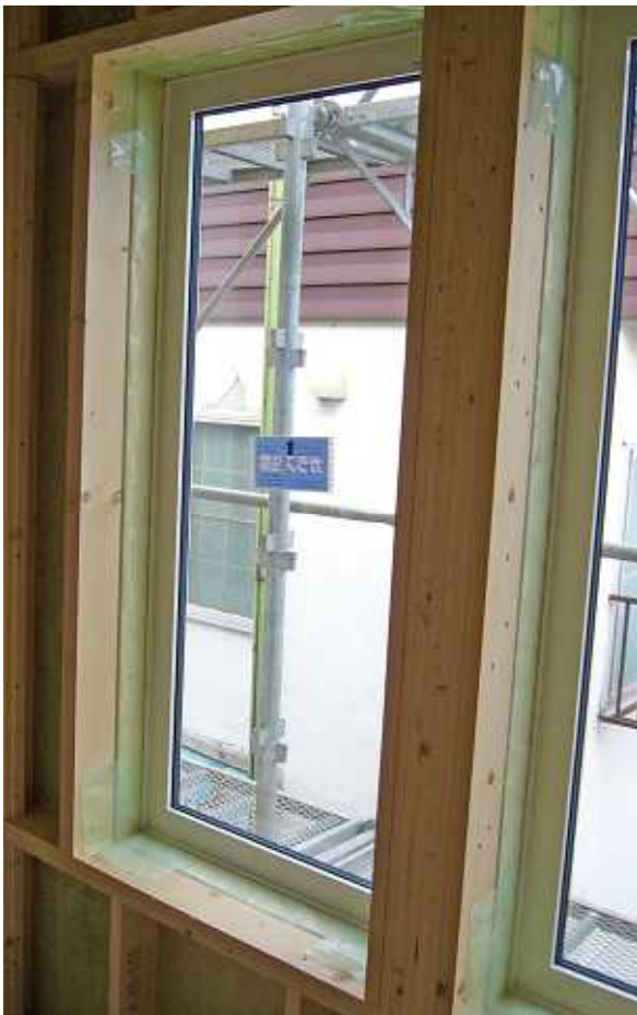
開口部まわりの施工例 （室内側）
