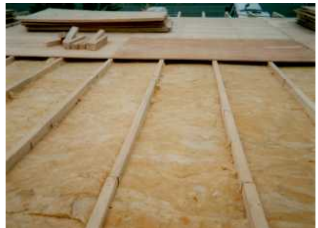
⑨屋根下地材の施工
