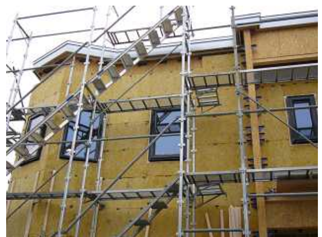
③ロックウールボード取り付け
