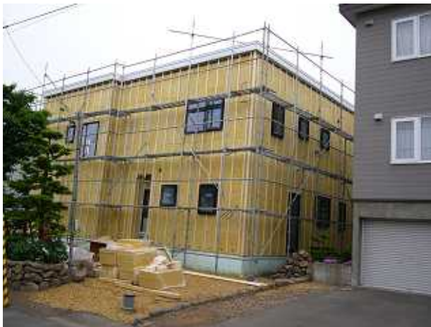
④ロックウールボード取り付け ～ 縦胴縁取り付け
