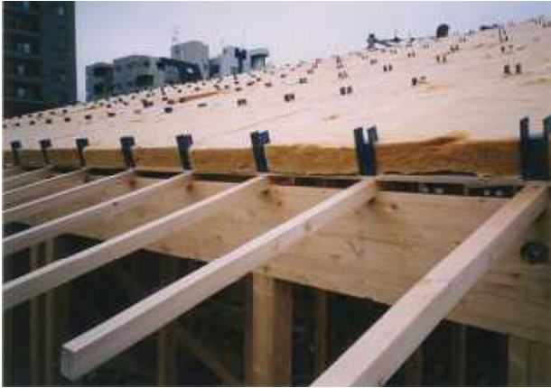
①ロックウールボード一層目（100 mm厚）取り付け
